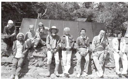
電気が復旧しない中、設置したソーラーパネルの前で (写真左から5番目が筆者)
