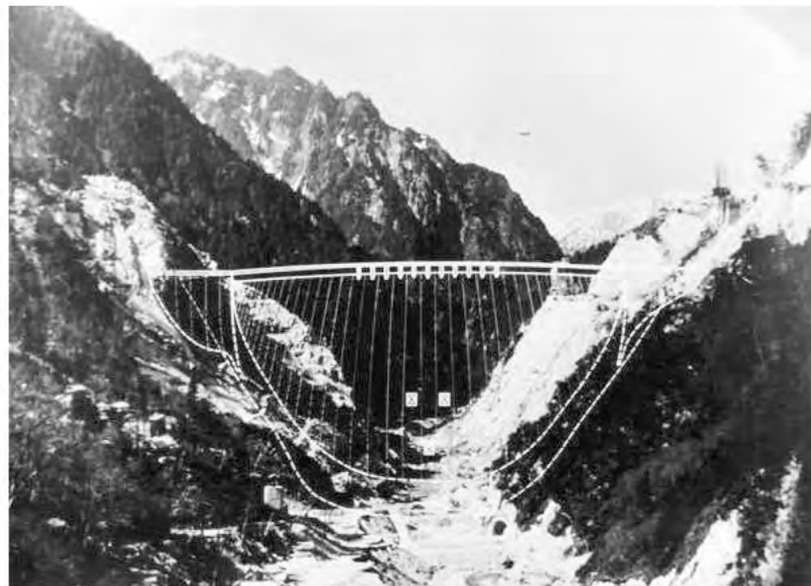
黒四建設予定地
