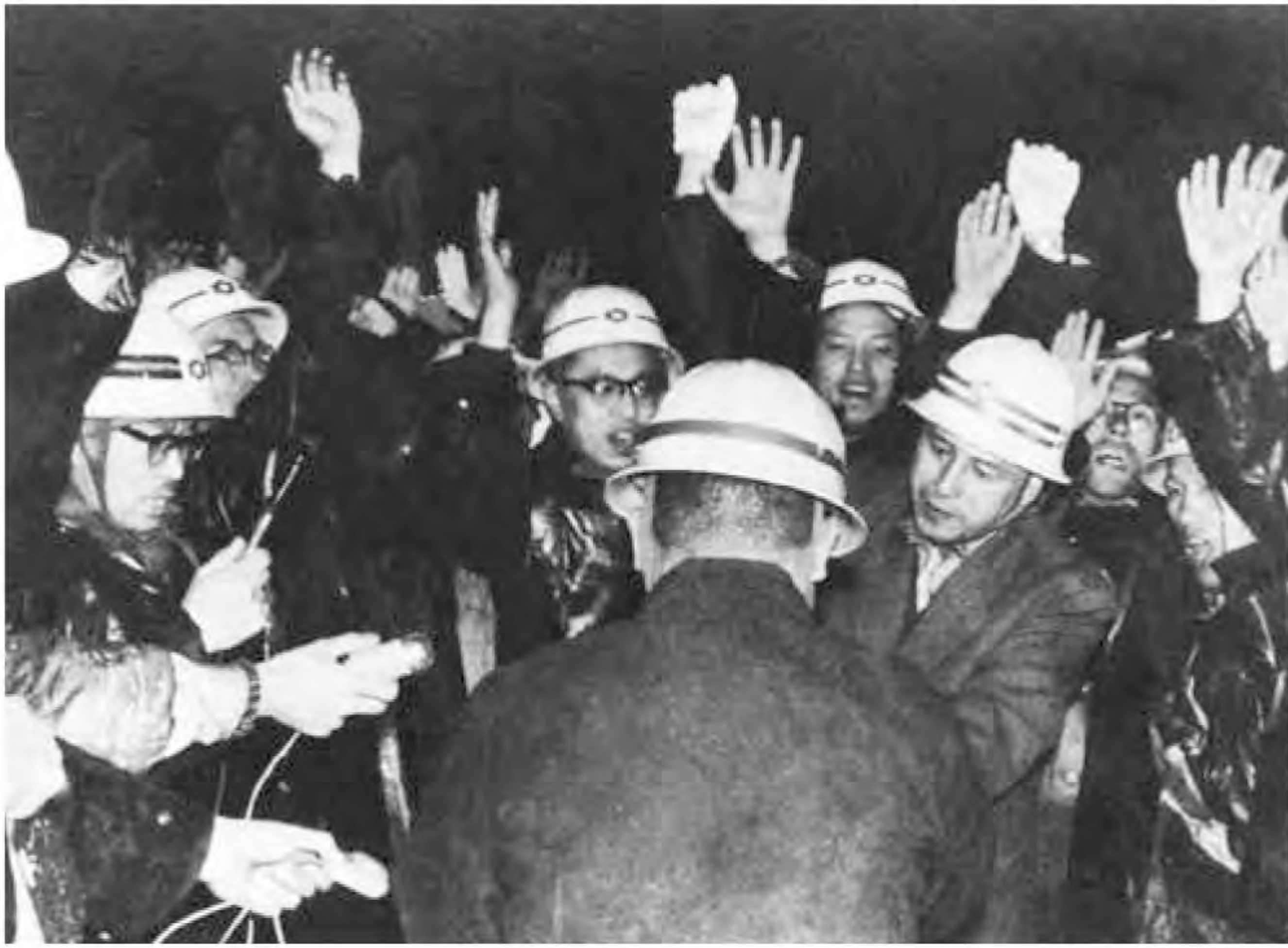
関電トンネル貫通
