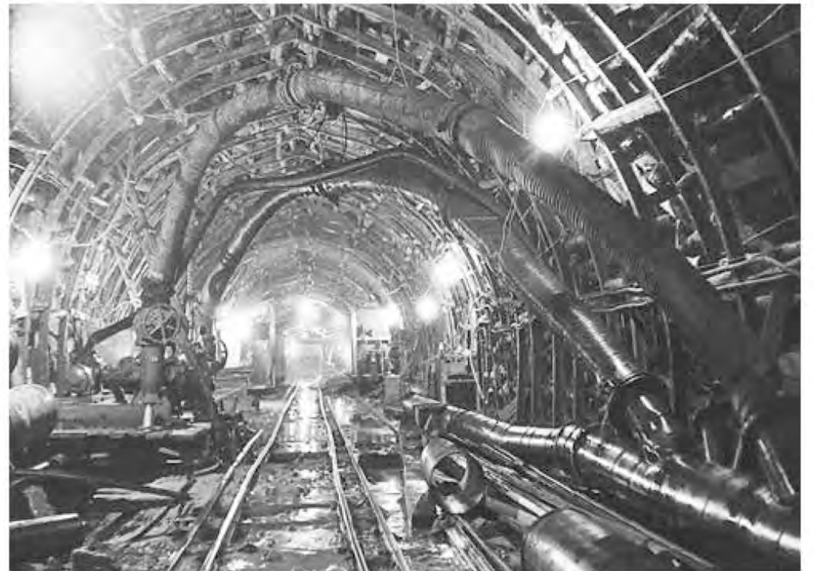
破砕帯突破中の大町トンネル
