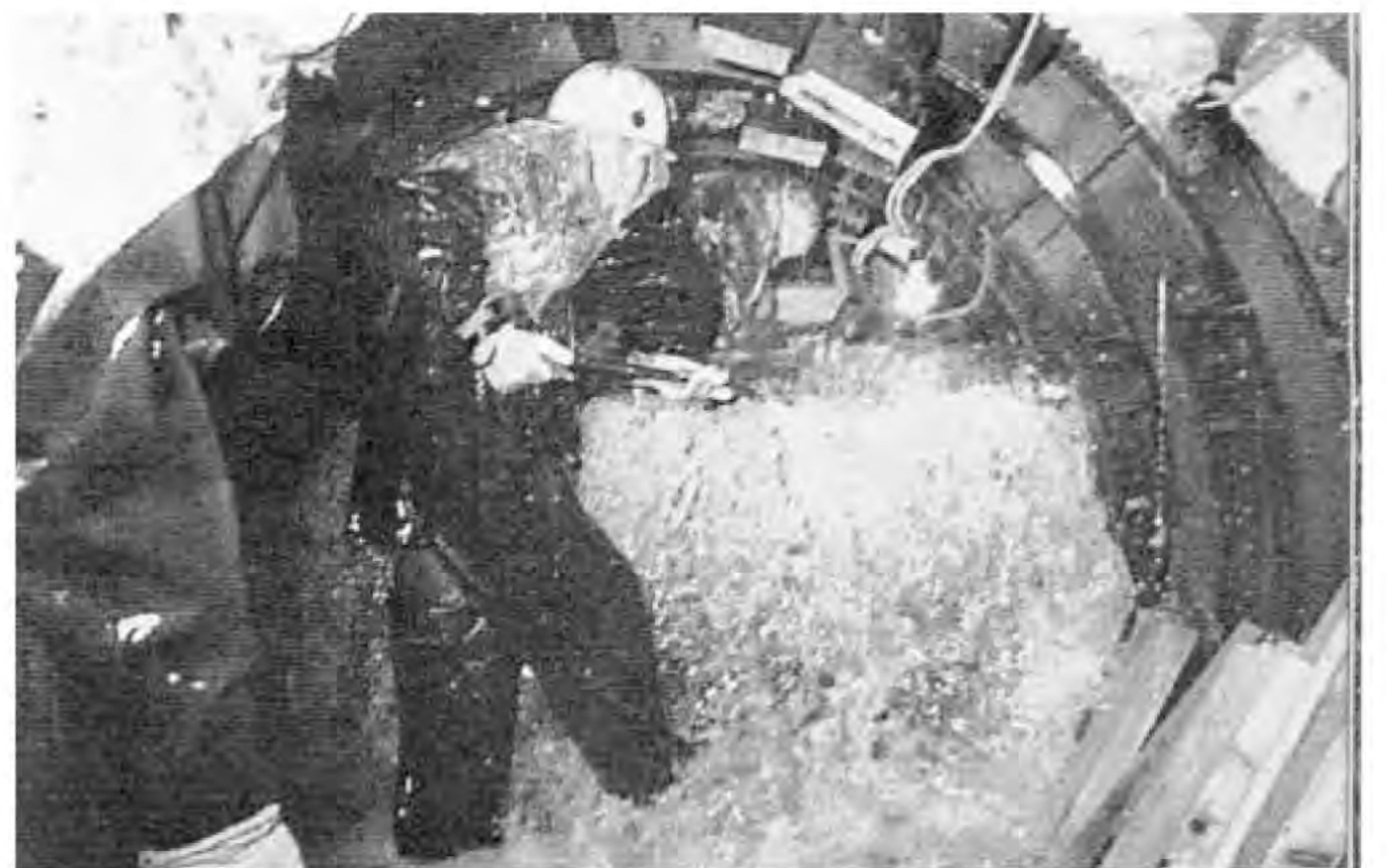
水抜きトンネル
